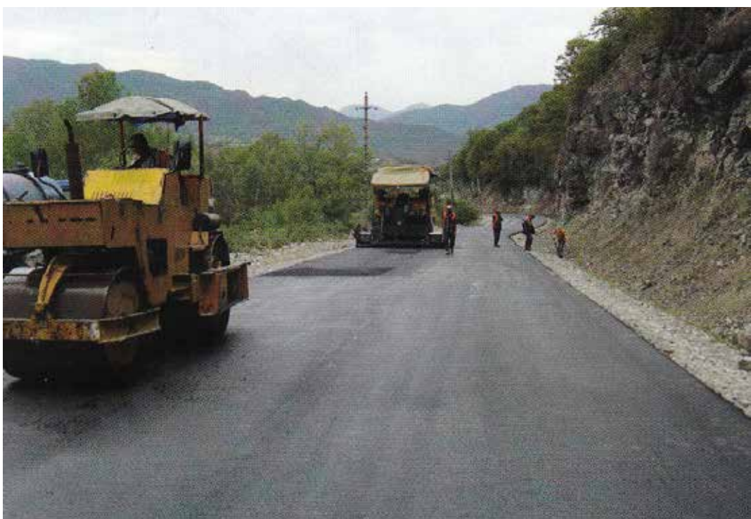
Le dernier tronçon de la nouvelle route sera achevé avant l'été 2016.
